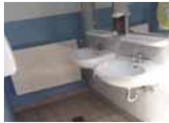
Zustand vor Baubeginn (l.) und danach.
