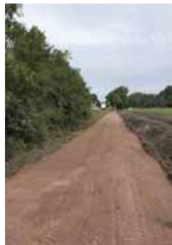
Frostschutz- und Schottertragschicht wurden im gesamten Bauabschnitt eingebaut.
