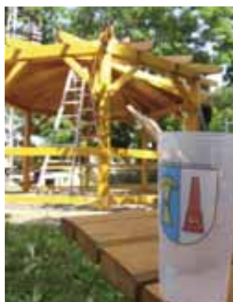
Richten des Pavillons in Lüttgenitz
