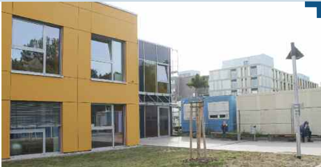
Direkt an den ersten Bauabschnitt Gebäude D schließt sich der zweite an.
