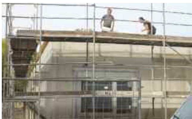
Mit der Ausbringung von Kies, der der Dachfolie den entsprechenden Halt geben soll, wurde das Dach des zweiten Gebäudetraktes Haus D im September abgeschlossen.
