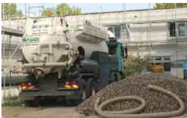
Mit der Ausbringung von Kies, der der Dachfolie den entsprechenden Halt geben soll, wurde das Dach des zweiten Gebäudetraktes Haus D im September abgeschlossen.
