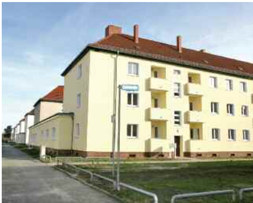
Das Wohnhaus Curiestraße 58-58 b in der gleichnamigen Siedlung wurde nach modernen Maßstäben und dennoch denkmalgerecht saniert.
