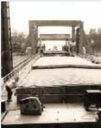
Der **Schiffsfahrstuhl** in Rothensee, 1938 eingeweiht, hebt die Schiffe von der Elbe in den Mittellandkanal. Generationen bewunderten das technische
