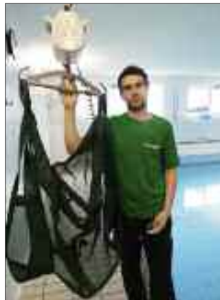
Für Menschen mit Handicap gibt es einen Lift, mit dem sie sicher ins Wasser gleiten und zurück an den Beckenrand transportiert werden können.
