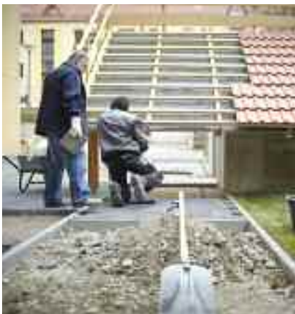
Sieht aus wie eine Baustelle, ist aber das Außengelände der Arbeitstherapie, auf dem u. a. Pflaster- und Dachdeckerarbeiten möglich sind.
