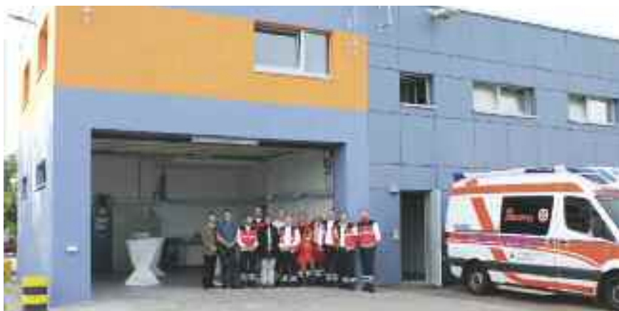
Mitte September wurde dieser Erweiterungsbau der Rettungswache am KLINIKUM MAGDEBURG seiner Bestimmung übergeben.
