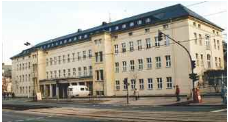
Das Stadtkrankenhaus, wie es die Hallenser aus DDR-Zeiten kennen. Nach dem Abriss dieses Gebäudeteils erscheint das gesamte Klinikgelände offener, freundlicher.
